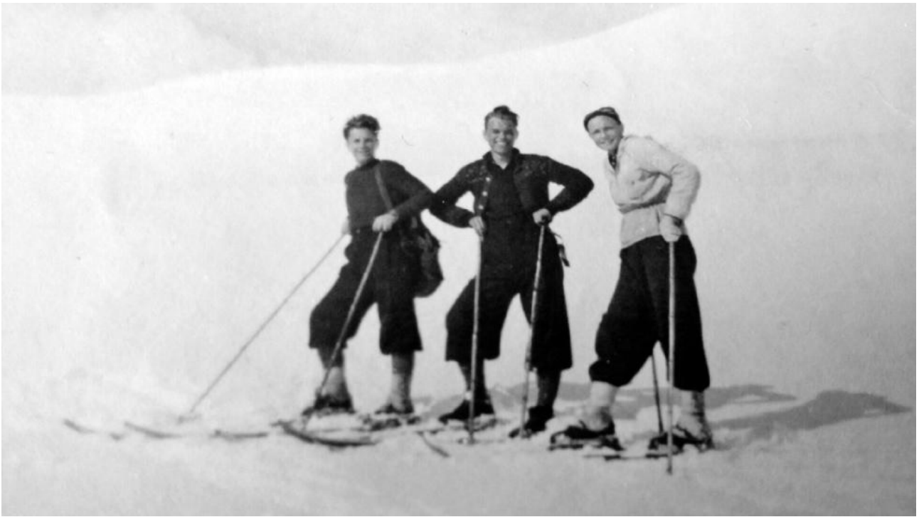
AUGNEVITNE: Johannes Kvammen (t.h.) var fyrbøtar på nattoget som frakta landssvikfangar og vaktene deira til Upsete for å vera med på redningsarbeidet. Dei to syskenborna hans, Johannes og Arnfinn Graue stod i vindauga på Hornvestølen og såg raset ta ungdomane på andre sida av dalen. Biletet er teke palmesundag 1947, same dagen raset gjekk. FOTO PRIVAT
